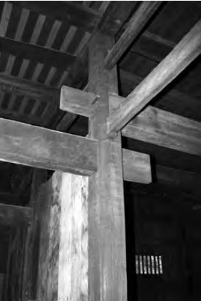
[5] Encuentro de un soporte interior con vigas y dinteles a distinto nivel mediante espigas pasantes aseguradas con clavijas y cuñas. Casa Yamada, Nouka Gassho-zukuri . Declarada "Importante Propiedad Cultural de la Prefectura de Kanagawa". Originalmente construida en Nanto, Toyama, a comienzos del siglo XVIII. Actualmente se encuentra en Nihon Minkaen: Japan Open-Air Folk House Museum , Kawasaki. Fuente: reportaje propio (noviembre 2014).
