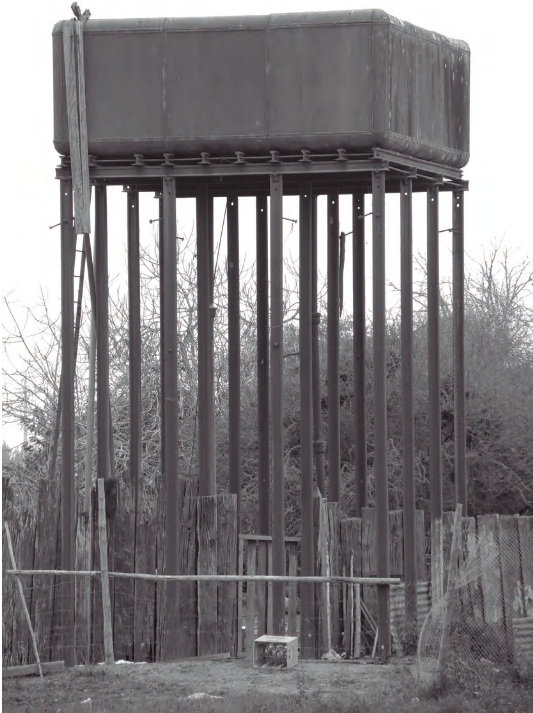
Torre de agua de hierro y rieles de tren. Alcones, Marchigue, VI Región, Chile. Fotografía: Camilo Palma
