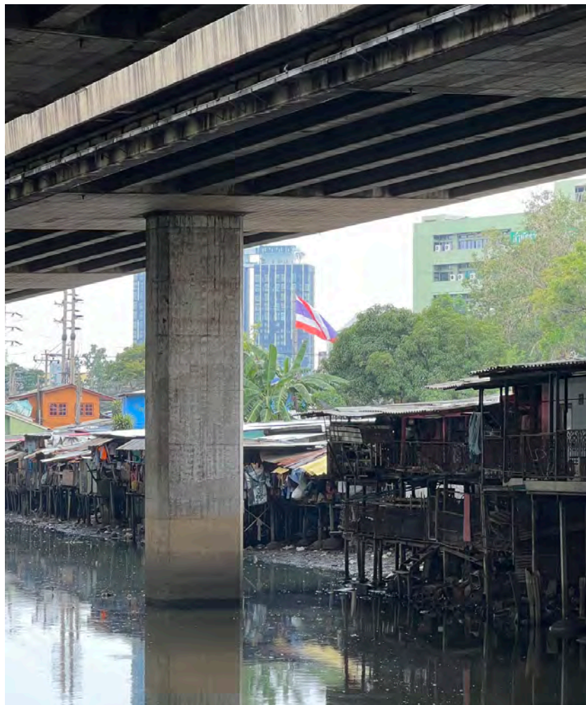
figura 5 Chabolas bajo una autopista de peaje en el canal de Khlong Toei, Bangkok. Fuente: autor, 2022.
