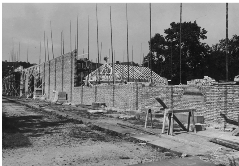
figura 9 Reconstrucción del cerramiento de las nuevas arcadas en el tramo más afectado, con la nueva cubierta del lapidario al fondo. Fotografía. Autor desconocido. 9/3/1953. Stadtarchivs München, signatura DE-1992-FS-NK-STB-0038.
