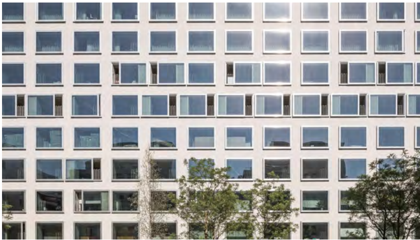
figura 13 E2A Edificio de Usos Mixtos Bethanien Zurich 2107.
